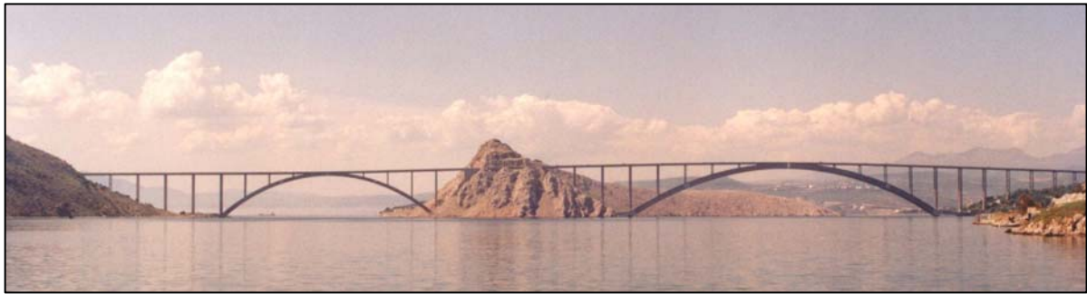
Slika 1. Krčki most – najveći klasični armiranobetonski lučni most na svijetu
