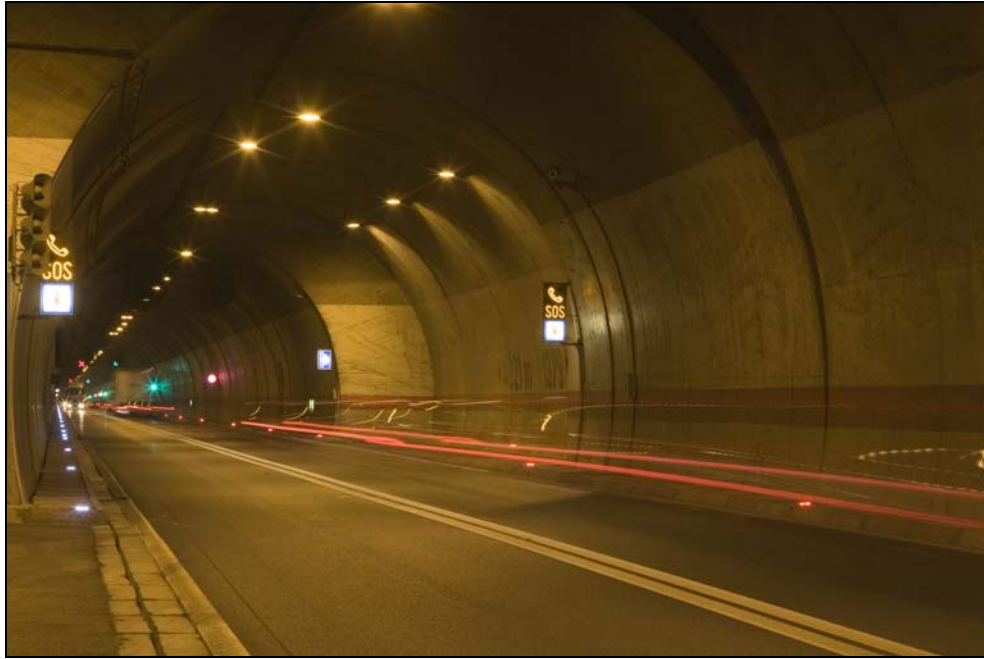
Tunel Mala Kapela
